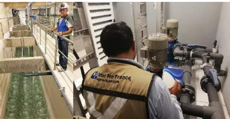
BIO PRO S® (concreto / confinado) 600 M 3 /Día
